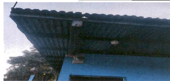
Foto 4: Mantenimiento a estructura de metal modulo 1
