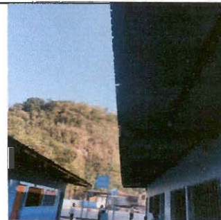
Foto 6: cambio de lámina de los 2 modulos.
