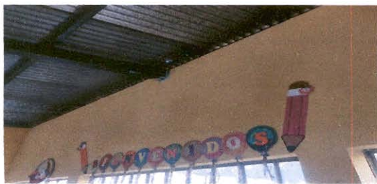
Foto 5: Mantenimiento a estructura de metal modulo 2
