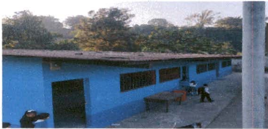
Foto1: Cambio de lámina modulo 1, 3 aulas
