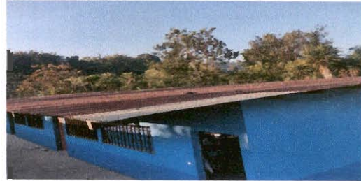
Foto 2: Cambio de lámina modulo 2, 3 aulas y 2 modulos de baño
